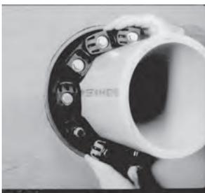
Faire glisser l'ensemble Micro Seal dans l'espace annulaire (cavité en forme d'anneau entre le tube et le mur). Pour les chaînes de plus grande taille, commencer par insérer la traversée de mur à 6 heures et remonter les deux côtés vers midi, dans l'espace annulaire.
