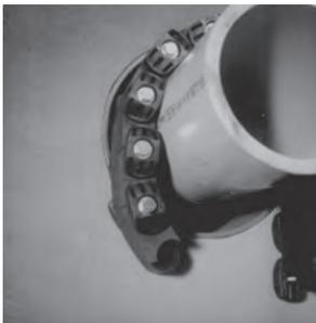
Desserrer les boulons de la plaque de pression juste ce qu'il faut pour que les chaînes puissent bouger librement. Raccorder les deux sections de la traversée de mur autour du tube.
