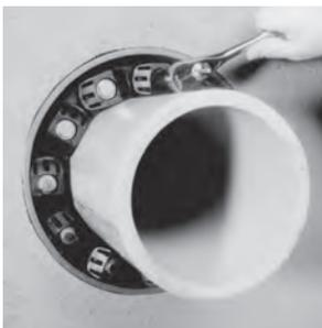
Serrer à la main en utilisant uniquement une clé de raccord ou une simple clé. Ne pas effectuer plus de 4 tours à la fois pour serrer les boulons. Serrer les boulons en les entrecroisant ou en séquence jusqu'à ce qu'ils soient tous uniformément vissés. Répéter cette manœuvre quelques heures plus tard pour garantir un serrage durable des boulons.
