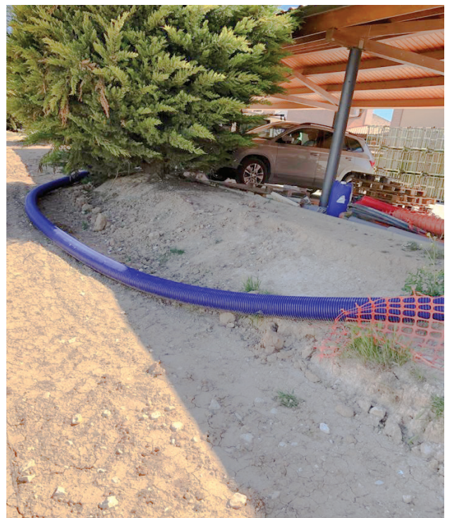
Sistema de tuberías flexibles preaisladas Microflex
