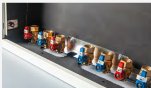
Vorinstallierte Anschlussleiste mit Kugelhähnen
