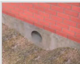
1. Eine Bohrung je nach Mindest- und Höchstabmessungen herstellen.
