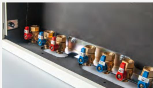
Vorinstallierte Anschlussleiste mit Kugelhähnen
