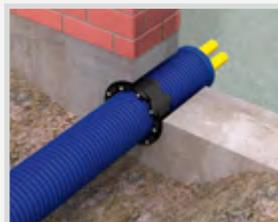
3. Das Rohr samt Kettenabdichtung in die Mauerbohrung schieben.
