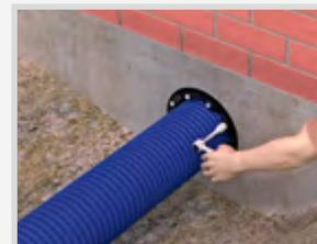
4. Durch Anziehen der Bolzen an den Gelenken, die im gleichen Abstand zueinander liegen, werden die Druckplatten gleichmäßig eingespannt und füllen den ringförmigen Hohlraum zwischen Rohr und Mauerbohrung.
