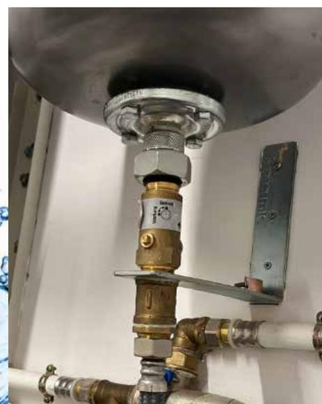
A compensazione delle variazioni di volume del fluido termovettore presente nel circuito di riscaldamento è stato installato il **vaso di espansione ACS/AFE** che evita che l'aumento della pressione nell'impianto possa danneggiare tubi e componenti.
