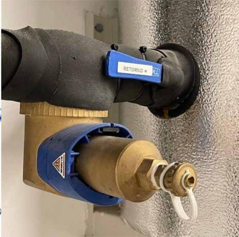
Il **defangatore magnetico WSS** rientra tra questi: si tratta, in particolare, di un componente che, tramite un'azione meccanica che sfrutta la forza centrifuga dell'acqua, ha il compito di separare tutte le impurità che potrebbero trovarsi all'interno del circuito chiuso di riscaldamento quali sedimenti, residui ferrosi, fanghiglia, calcare, ecc...
